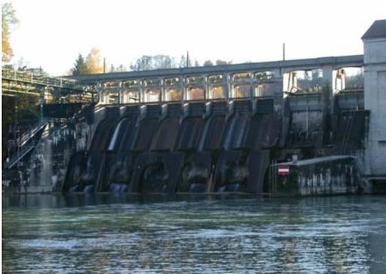
**Mittelland:** Flusskraftwerk mit AAR-Schäden
