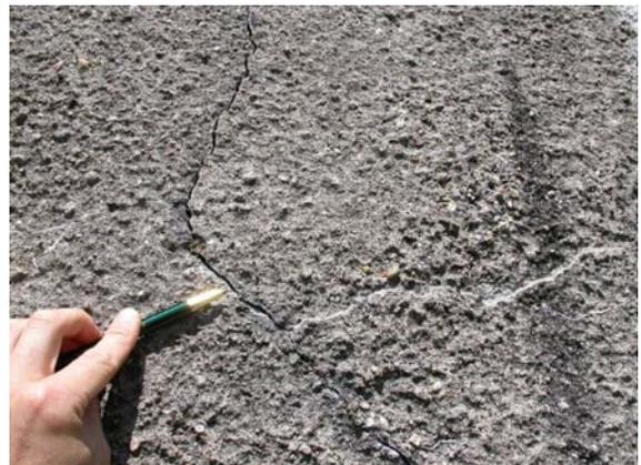
Nordostschweiz: AAR-Schäden bei einer Stützmauer
