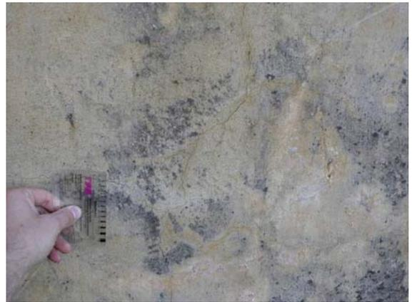
Tessin: Überführung mit AAR-Schäden in den Flügelmauern
