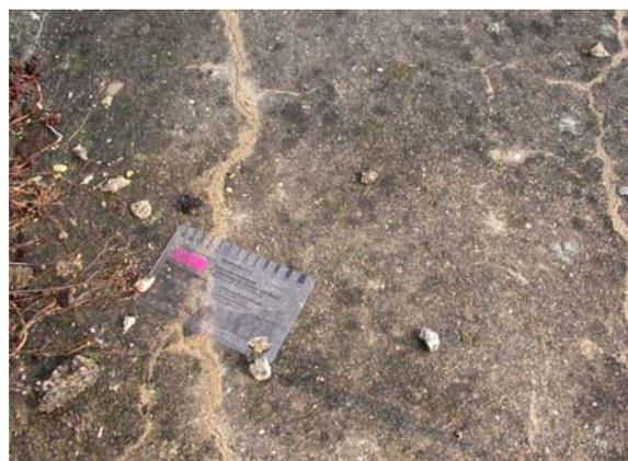
**Jura-Südfuss: AAR-Schäden bei einer verankerten Stützmauer**
