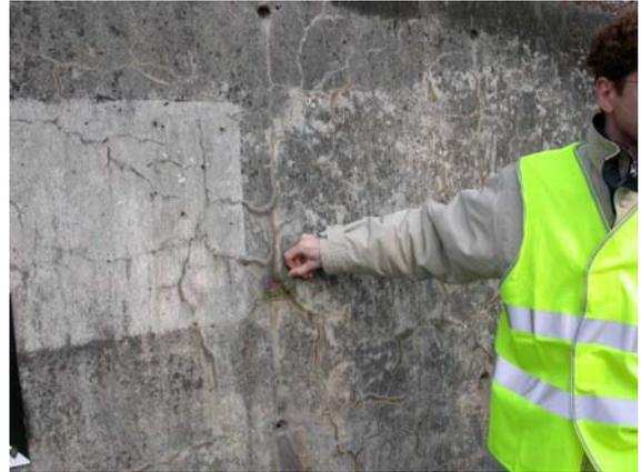
**Jura-Südfuss: AAR-Schäden bei einer verankerten Stützmauer**
