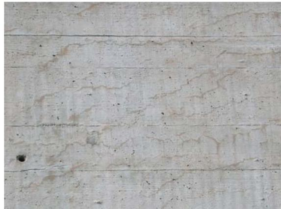
**Alpen, Wallis: AAR-Schäden an den Seitenwänden des Brückenkastens**
