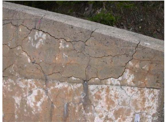
Alpen, Wallis: Stützmauer mit AAR-Schäden im Mauerkronenbereich
