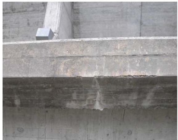
Alpen, Wallis: AAR-Schäden bei einer verankerten Stützmauer
