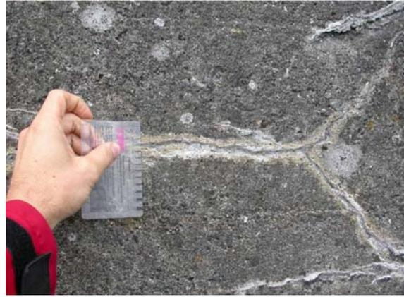
**Nordostschweiz: AAR-Schäden bei einer Stützmauer**
